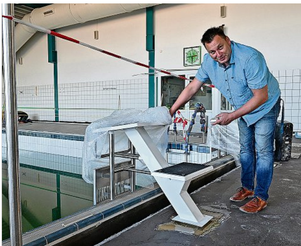
Matthias Brauer, Geschäftsführer des Lausitzbades Hoyerswerda, schlägt hier fürs Foto die Schutzhülle eines der fünf neuen Startblöcke zurück, während im Hintergrund die neuen großformatigen Bodenfliesen verlegt werden.
