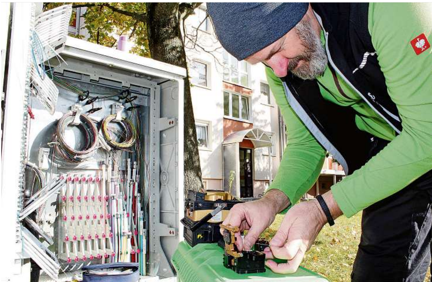
Kabelmax-Monteur André Langner fügt an einem Schaltkasten eine Glasfaser aus dem Netz mit einem Heimanschluss zusammen.
