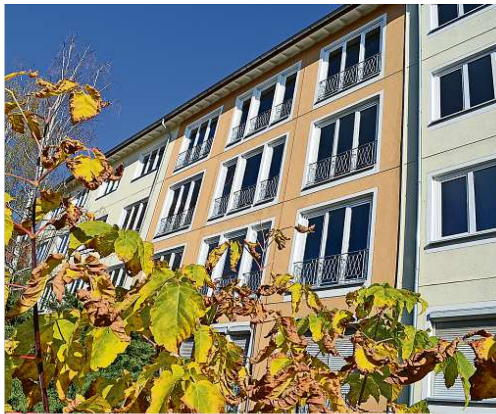
Eigentlich Abrisskandidat, jetzt aber zunächst gerettet: das Gebäude Günter-Peters-Straße 1 bis 7 im WK I. Foto: Sascha Klein
