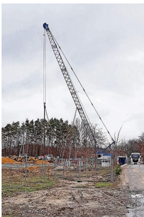
Seit Januar ist Rüttel-druckverdichtungstechnik am Knappensee direkt am Rundweg in Koblenz zu sehen. Gerüttelt wird laut LMBV seit dem 6. Februar.
