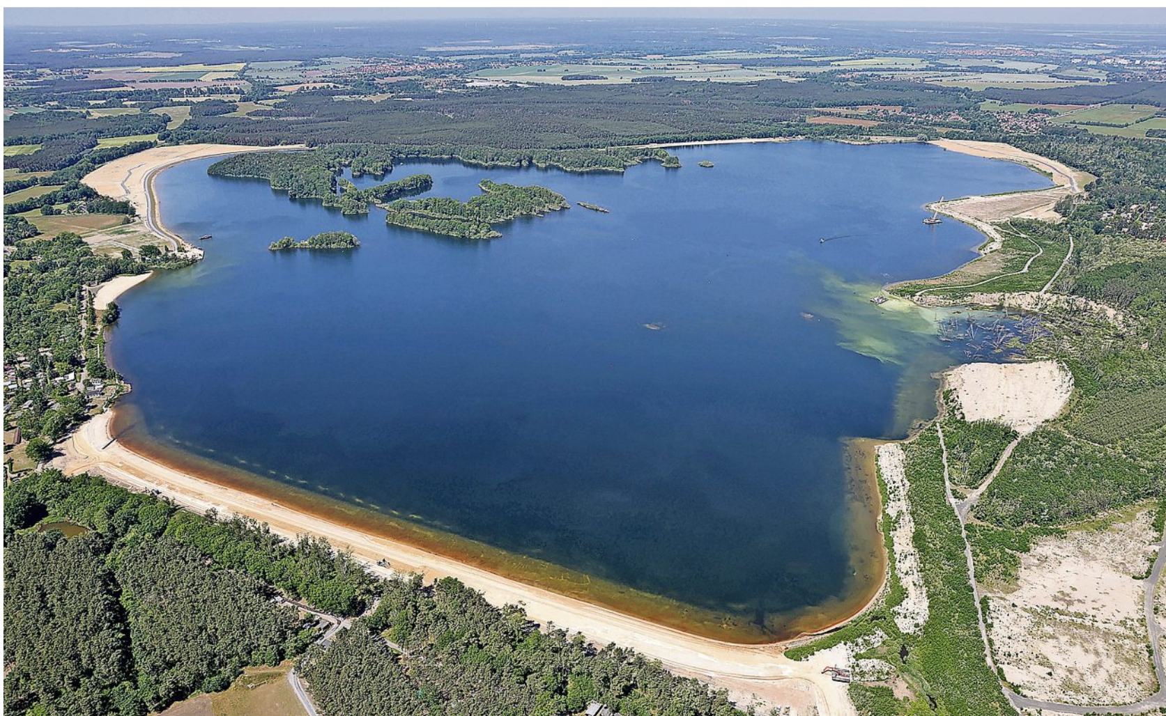
Diese Aufnahme des Knappensees stammt aus dem Mai 2023. Am rechten unteren Bildrand finden die jetzigen Sanierungsarbeiten statt.
