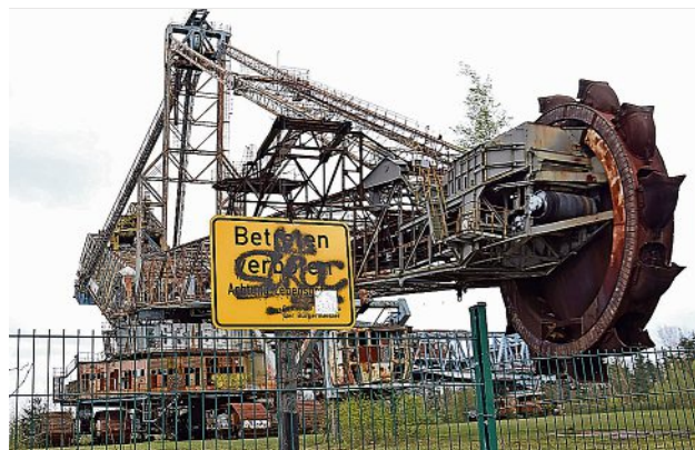
Das einst „Blaue Wunder“ ist nur noch rostbraun. Der Schaufelradbagger ist ein Hotspot für Vandalismus geworden, heißt es. Foto: Gemeinde Schipkau
