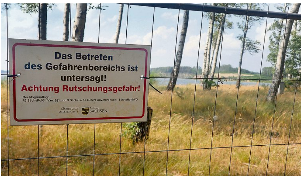
Blick auf den Rutschungskessel am Ostufer des Knappensees. Die Rutschung war am 11. März 2021. Damals brach die Ostböschung auf rund 500 Meter ein. Ungefähr eine Million Kubikmeter Erdreich rutschte in den See. Augenzeugen sahen eine 1,50 Meter hohe Schwallwelle. Auf der schräg gegenüberliegenden Seeseite erlitten einige Gebäude Schäden.
