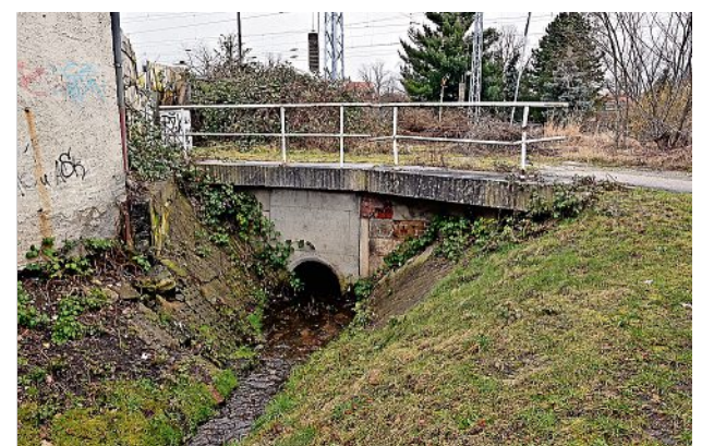
100 Meter östlich des Bahnübergangs Dresdener Straße/ Friedrichsstraße verschwindet das Bächlein Kossackgraben im Rohr.
