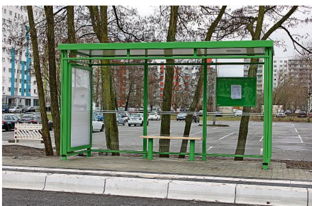
Die barrierefrei angelegte Bushaltestelle dient überwiegend dem Schülerverkehr und wird daher ausschließlich von Überlandbussen angefahren.
