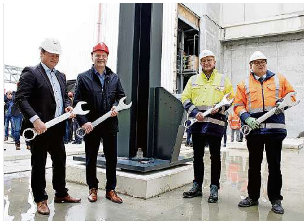
Die erste von 27 Kesselstützen wurde mit vier überdimensionalen Schraubenschlüsseln festgezurr. Foto: Mirko Kolodziej
