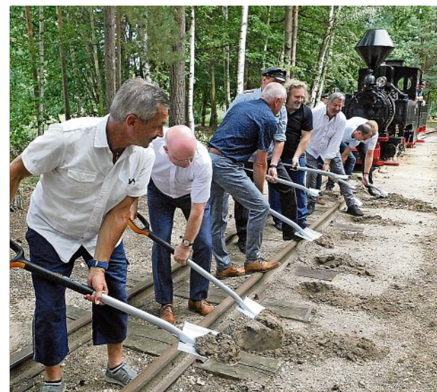
16 km Gleise, über 20.000 Schwellen und mehr als 40 Bahnübergänge werden saniert. Foto: Sabine Larbig
