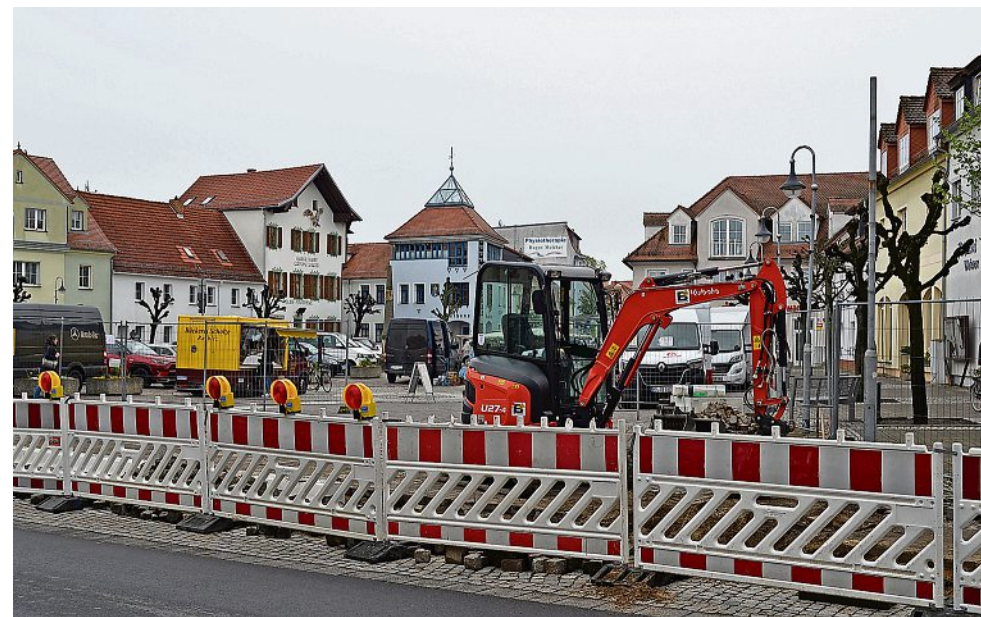
An einer Marktseite wird gebuddelt: Dort entsteht eine barrierefreie Bushaltestelle. Foto: Sascha Klein
