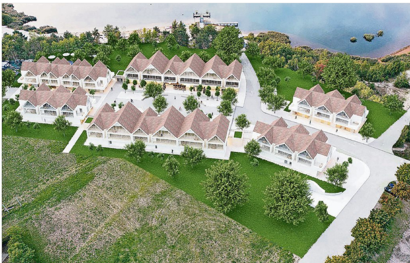
So soll es bald am Geierswalder See aussehen. Kern des Vorhabens „Servicegelände“ ist ein zentraler Platz mit geschlossener Bebauung, wo sich Ferienunterkünfte und kleinteilige Nutzungen finden sollen. Dabei wird unter anderem an Einzelhandel, Gastronomie und Dienstleistungen gedacht.
