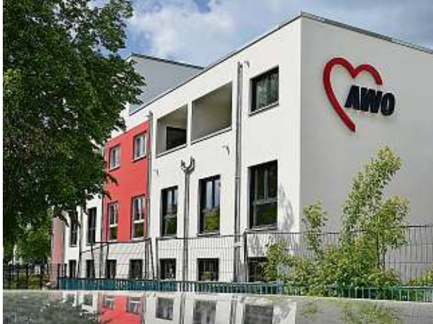
Noch sind die Bauarbeiten an der Erich-Weinert-Straße in vollem Gange. Demnächst geht es an die Inneneinrichtung des neuen Wohnheims. Foto: Sascha Klein
