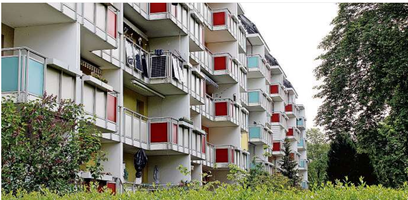
Die Fünfgeschosser an der Geyerstraße im WK IX gefallen vielleicht der Stadtplanung nicht unbedingt, den Bewohnerinnen und Bewohnern dagegen schon. Foto: Mirko Kolodziej
