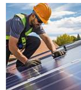
Gefragt wie selten zuvor: Dachdecker, die sich auch mit Solarinstallationen auskennen, sowie viele weitere Fachkräfte mit sogenannten „green Skills“. Foto: Adobestock
