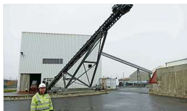
Anlagenleiter Robert Wagner bei Kontrollgängen in der stillstehenden Anlage der VTRA. Foto: Jost Schmidchen
