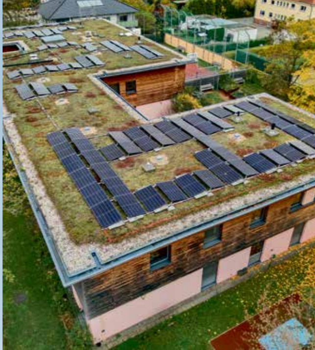
Foto: Solar Netzker
