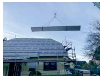
Wirksame Abhilfe schafft eine effiziente Aufsparrendämmung, etwa mit LINITHERM PAL XXL Dämmelementen. Sie empfiehlt sich allein schon deshalb, weil der Staat mit seinen Energiegesetzen die Messlatte für den sommerlichen Wärmeschutz immer höher legt.
